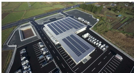
笠間太陽光発電所(笠間センター)
