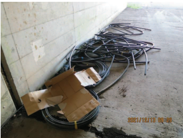
羽刈地内 高速隧道 ケーブル類
