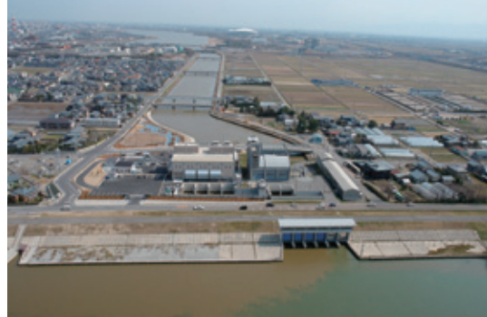
水田に農業用水を供給する親松排水機場
