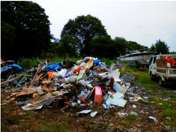
中野谷地内 解体ごみ 民地
