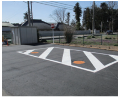
外之内公民館敷地内に設置された、耐震性を備えた防火水槽
