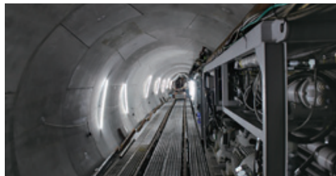
建設中のトンネル
