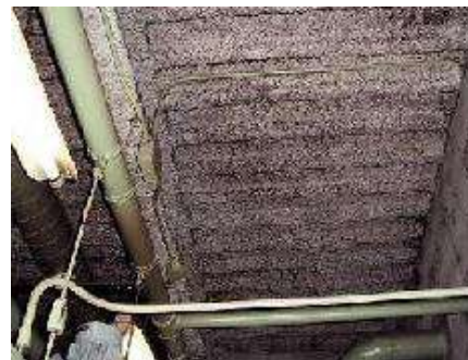
石綿含有スレート波板(屋根・外壁)
