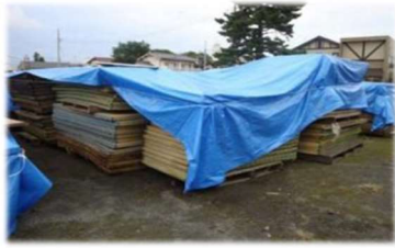
置は高さ2m以下程度に積み上げ風通しを良くする 平成27年(2015年)関東・東北豪雨の栃木市の仮置場
